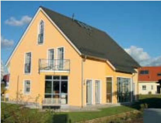
Bild 23: Gemessenes Fertighaus aus Hochlochziegeln (Meßkurve 5)
